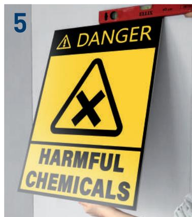
Utilizzare una livella per il montaggio del pannello al muro, assicurandosi di pressare bene la zona ove è montato il fissaggio.
